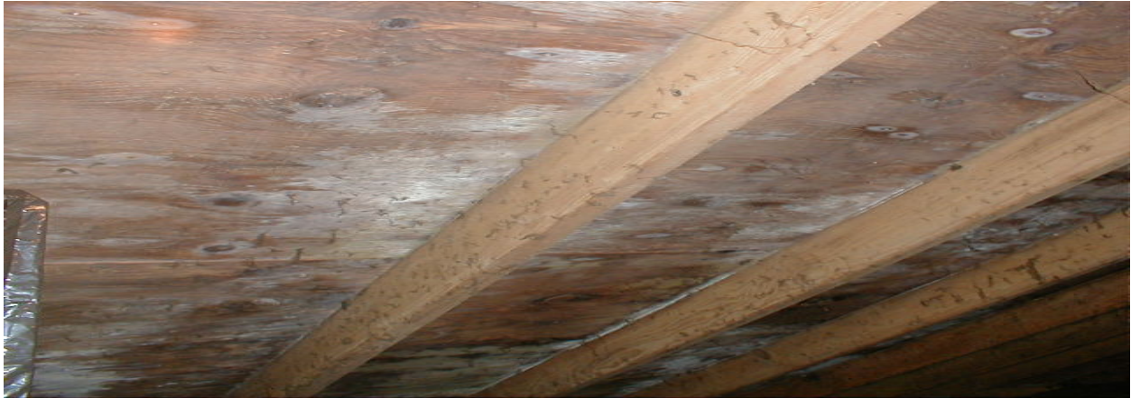
Figura 8. Condensación: moho en el revestimiento del techo en un ático. Durante los meses de invierno, la humedad (vapor del agua) que sale por el techo de las zonas habitadas, con la fuerza del aire tibio ascendente, se condensa en el revestimiento del ático frío. Esto causa daños a la propiedad y exposición al moho para los inquilinos. Si este problema se deja sin corregir, el techo se dañará y deberá ser reemplazado.
