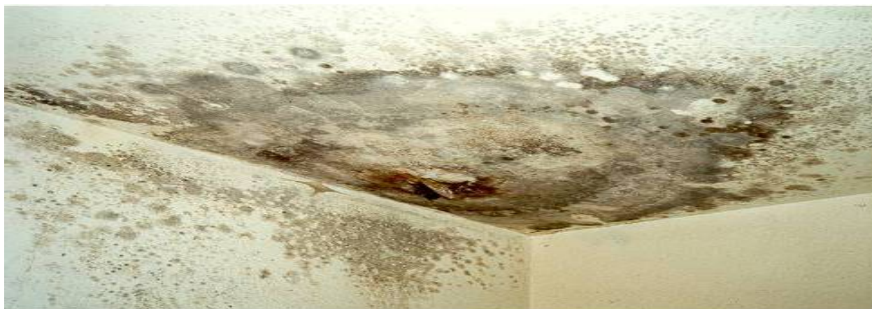
Figura 10. Fuga del techo o las tuberías: si se deja sin reparar, una fuga pequeña puede convertirse en un gran problema. Para prevenir la contaminación adicional de las pertenencias de los inquilinos, este panel de pared debe quitarse utilizando equipo de protección personal y un cerco plástico bajo presión negativa con salida hacia el exterior. El moho habrá crecido en el techo y las cavidades de la pared, y será necesario que lo eliminen trabajadores que usen equipo de protección personal.
