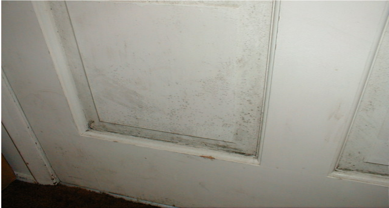
Figura 6. Condensación: crecimiento de moho en la superficie interior de una puerta hacia el exterior. Para reiterar, cuando una superficie fría entra en contacto con aire húmedo, se moja y se producen las condiciones necesarias para que crezca el moho. Esto puede lavarse y volver a pintarse.
