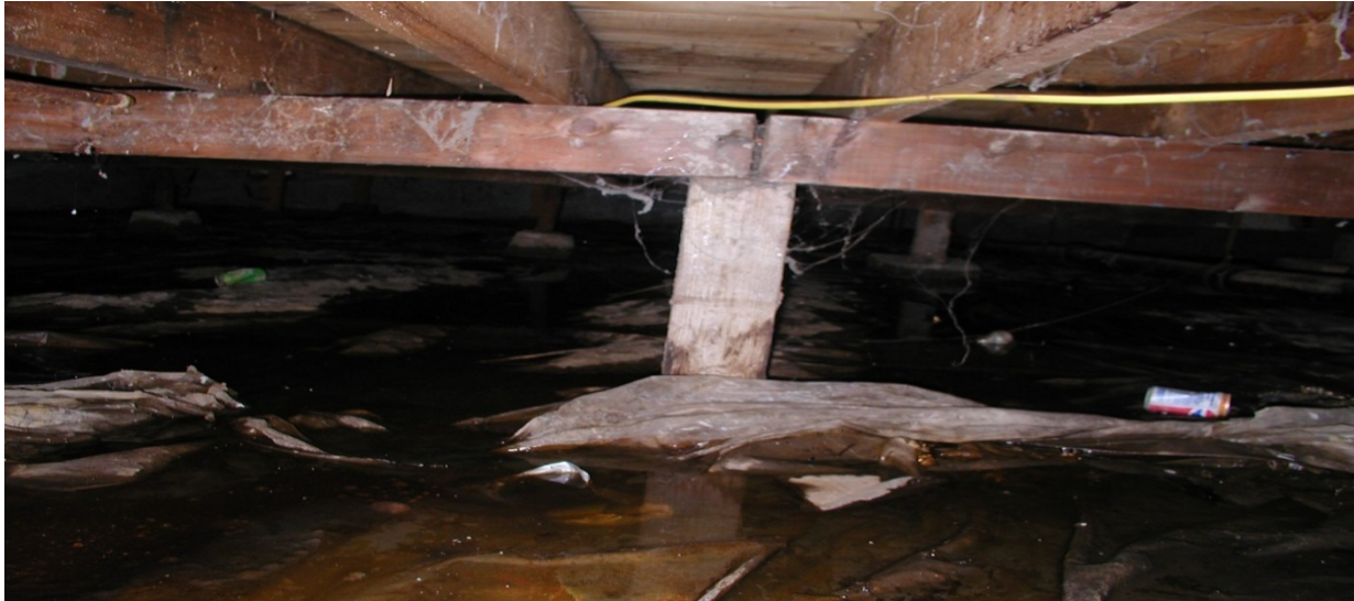
Figura 7. Agua empozada en un espacio debajo de la casa: el 40 % del aire que usted respira puede provenir del espacio debajo de la casa, que sube gracias a la fuerza del aire caliente en ascenso. El exceso de humedad en el espacio debajo de la casa es perjudicial para su salud y es dañino para la estructura. Además, es un factor importante en el desplazamiento de la humedad relativa hacia ARRIBA.
